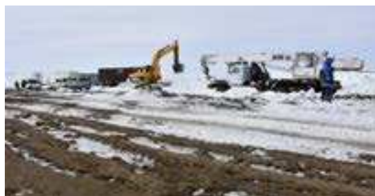
В настоящее время практически отсыпана дорога, ведущая к полигону ТБО
