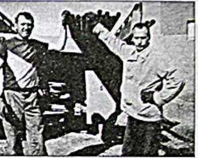
Строитель А.К. Гилев (слева), каменщик Н.М. Корюнов
