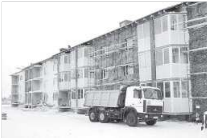
Строящийся 24-квартирный дом
