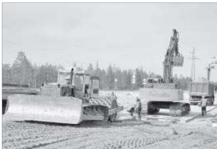
Обещание губернатора выполнено - на участке КС-02-Пурпе построена новая дорога
