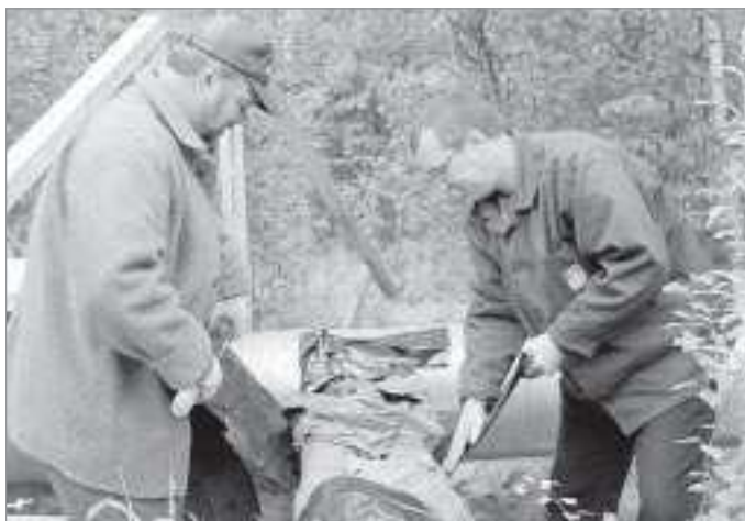
Замена утеплительного слоя теплотрассы
