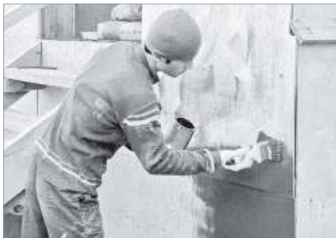
Текущий ремонт жилого дома
