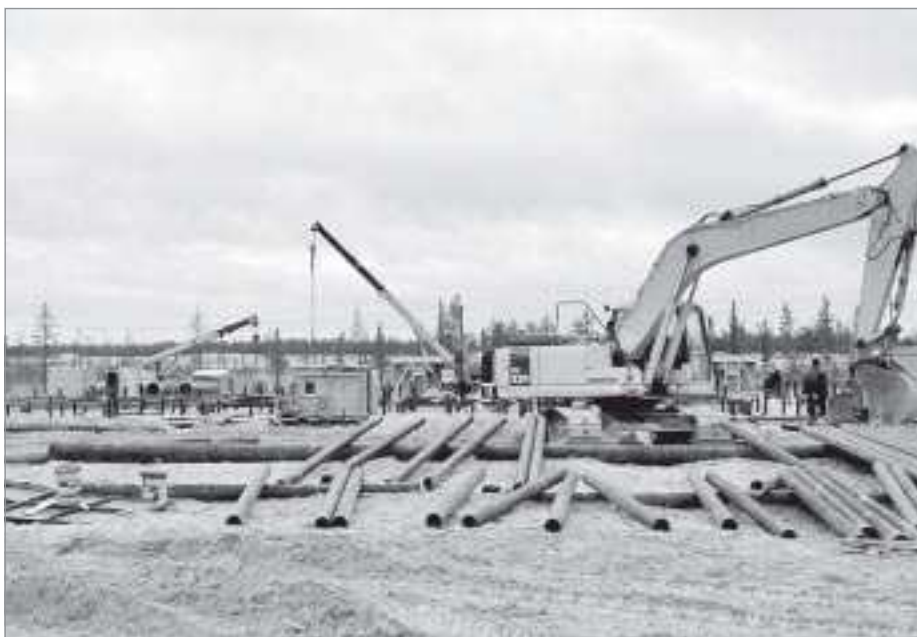
Строительство третьей очереди ДКС (сентябрь 2013 года)
