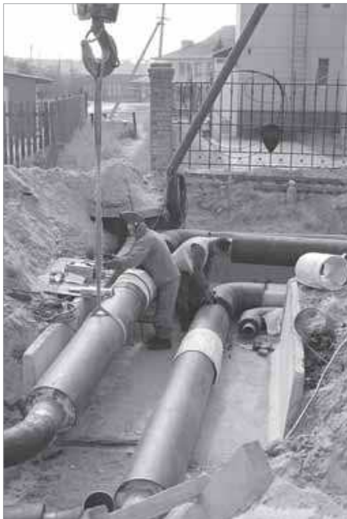
Замена участка сети тепло- и водоснабжения в районе КСК «Геолог»
