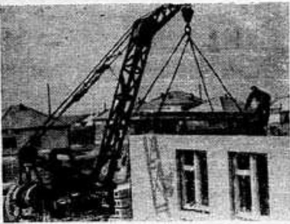
ПОЛТАВСКАЯ ОБЛАСТЬ. Правление колхоза имени Шевченко Карлоцкого района решило в нынешнем году построить в кредит для колхозников более 20 благоустроенных домов. Строительство ведет механизированная колония № 1 г-ста «Полтавсельхозстрой». На снимке: строительство жилых домов в колхозе. Фото П. Кекало. Фотохроника ТАСС
