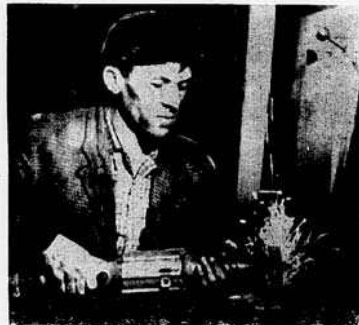
Четвертый год работает на энергопоезде специалист широкого профиля слесари-ремонтники Александр Гребенкин. Работает он, как говорят, с душой, вкладывая в любимое дело все свое умение и мастерство. Порой в тяжелых условиях приходится трудиться ремонтникам. Так было и во время ремонта энергопоезда. Наши неисправности в топке. И Александр со своими друзьями хорошо и в короткий срок устранил их. Социалистические обязательства в честь выборов в Верховный Совет СССР он выполнил успешно и намного раньше намеченного срока.
