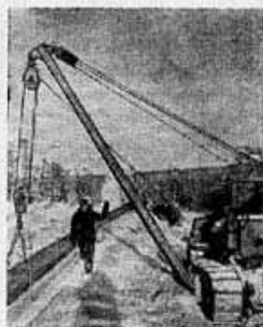
Все длиннее становится газопроводная линия, идущая с Сахалина на материк. В морозы и метели, в условиях суровой дальневосточной зимы ведут работы нефтепроводчики.
