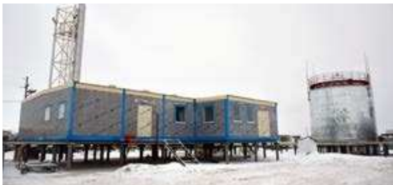
Новая котельная построена в микрорайоне Глубокое
