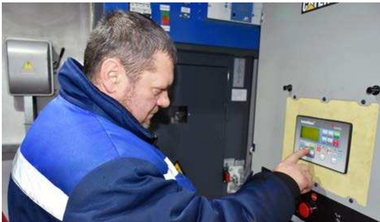
Павел Саев - ма- шинист электро- станции
