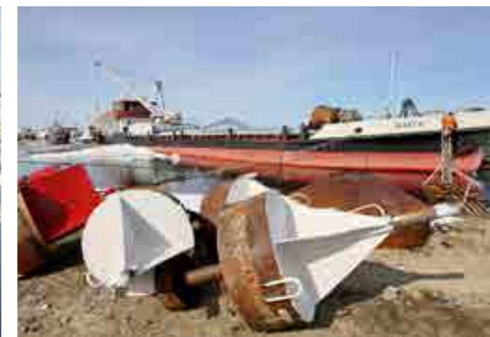
Параллельно с подготовкой «Бухты» речники приводят в порядок и навигацию, красят и где надо подваривают буи
