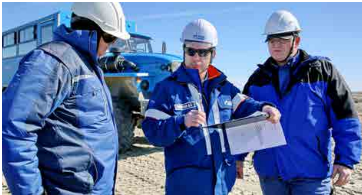
На совещании под руководством генерального директора «Газпромнефть-Развития» Дениса Сугаипова обсудили ход строительства напорного нефтепровода
