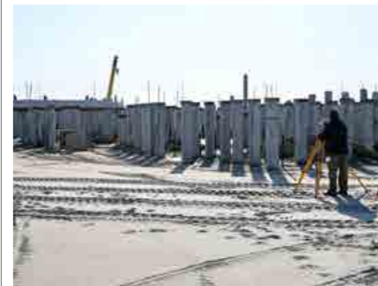
Специалисты Северной строительной компании занимаются возведением стен на одном из домов первой очереди микрорайона «Солнечный»
