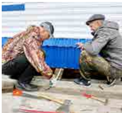
В период летних ремонтов мужчины становятся плотниками - на территории «Солнышка» им есть где развернуться: заменить доски или отремонтировать крыльцо
