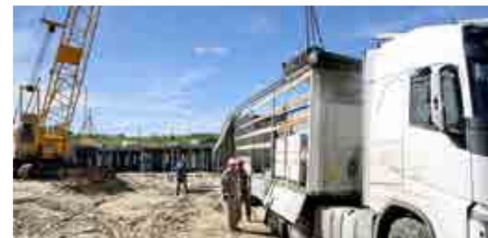
Цокольный этаж готов, строители приступают к укладке несущих стен 31-квартирника в микрорайоне Аэропорта
