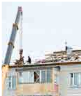
Капремонт кровли Геофизиков, 30, подрядчик должен завершить к 15 сентября
