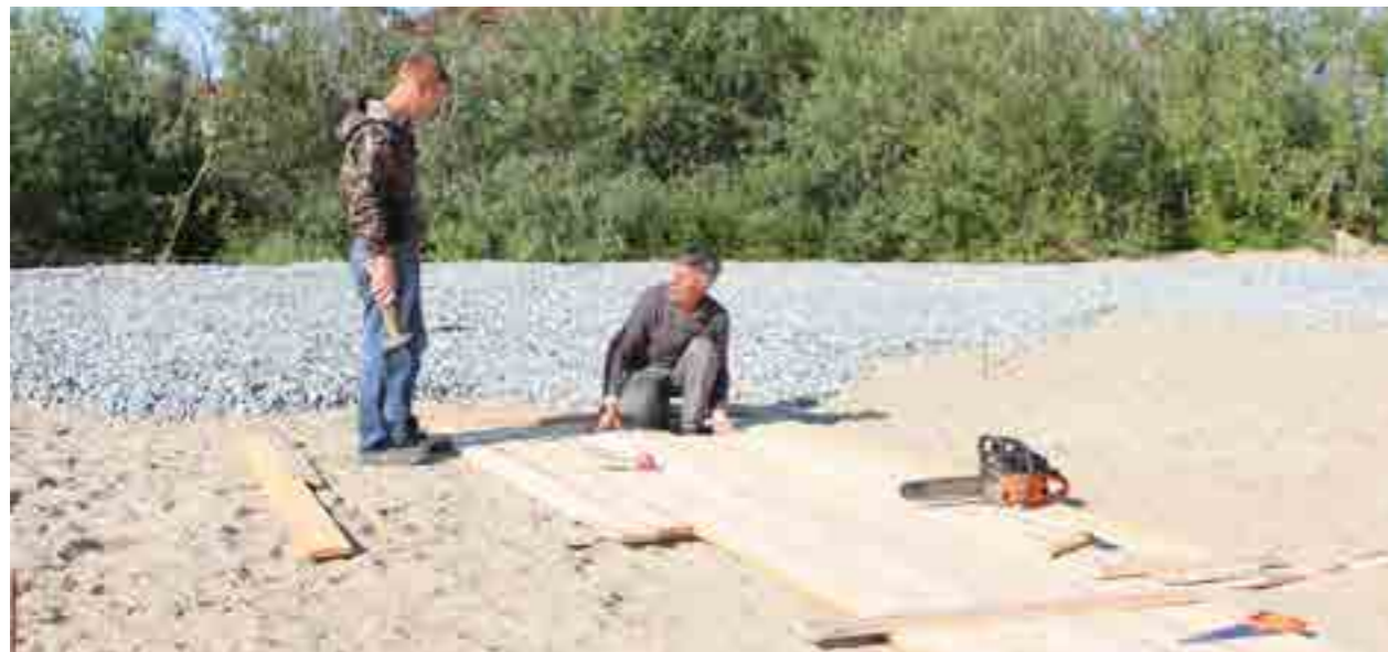
Рабочие фирмы «Карт» сооружают опалубку для основания монумента. Сами художественные композиции изготавливают в Тюмени
