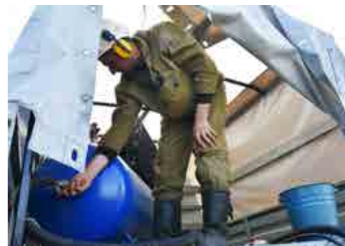
Слесарь-ремонтник Виталий Валькин следит за работой компрессора и проверяет давление, с которым воздух попадает в систему водоснабжения
