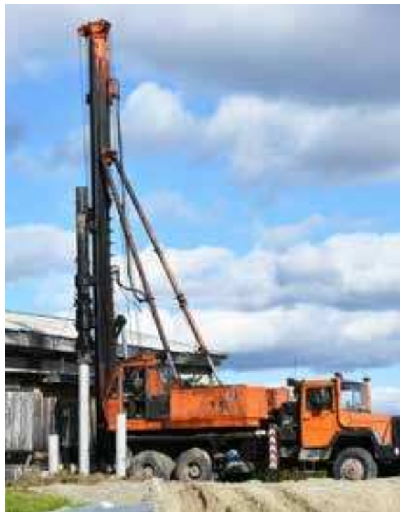
Строительство новой электростанции в Тазовском
