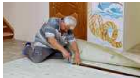
Ремонт близится к завершению
