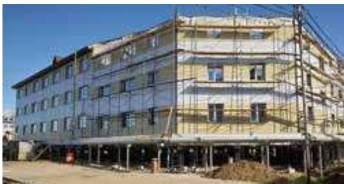
ООО «Строительное объединение Арктика» строит в Гыде четырёхсекционный многоквартирный дом
