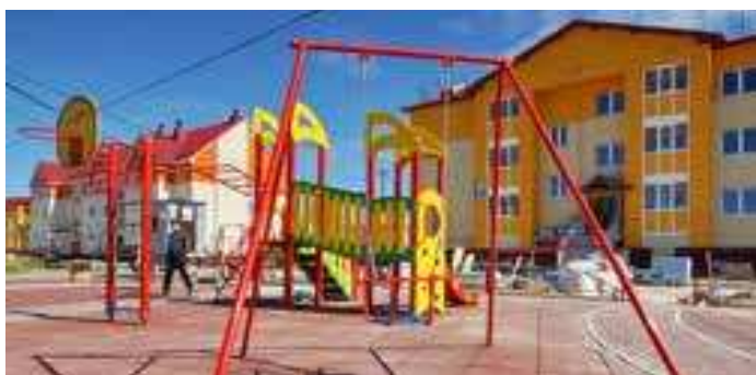
Последние штрихи: на двух 30-квартирниках в микрорайоне Калинина застройщики благоустраивают территорию
