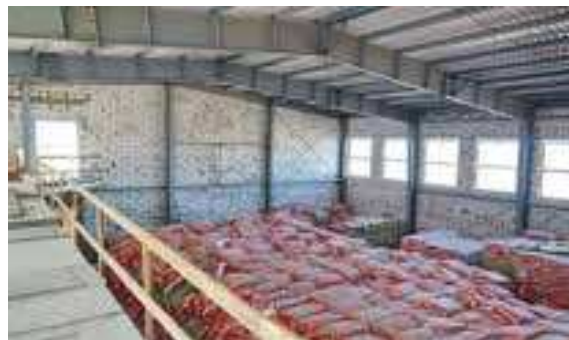
В спорт-зале будет уложено травмо-безопасное покрытие
